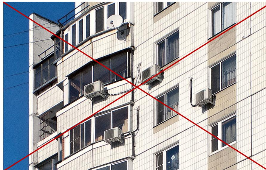
Пример НЕправильного размещения кондиционеров на внутривором фасаде
