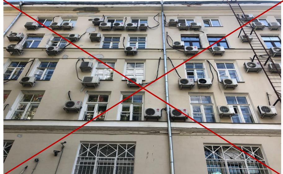
Пример НЕправильного размещения кондиционеров на внутридвором фасаде
