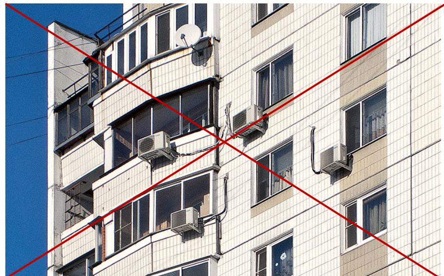
Пример НЕправильного размещения кондиционеров на внутридвором фасаде
